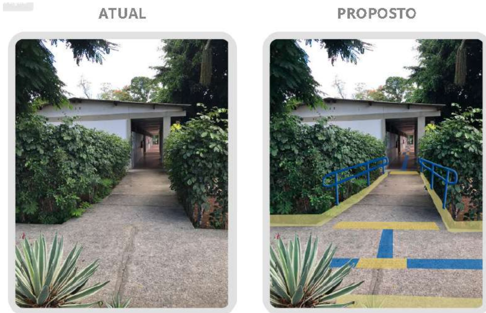
Figura 15: Acesso ao Bloco Administrativo.
